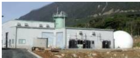
パイロットプラント全景
